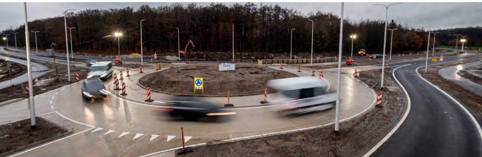
De Motis rotonde, gekoppeld aan de innovatieroute N737 in Twente. Dankzij geluidsdetectie weet de weg waar verkeersgebruikers zijn. De weg past zich daaraan aan. Verkeerslichten gaan langer op groen als er verkeer aanstaande is, hulpdiensten kunnen worden gealarmeerd als een ongeval plaatsvindt. Foto: Strukton
