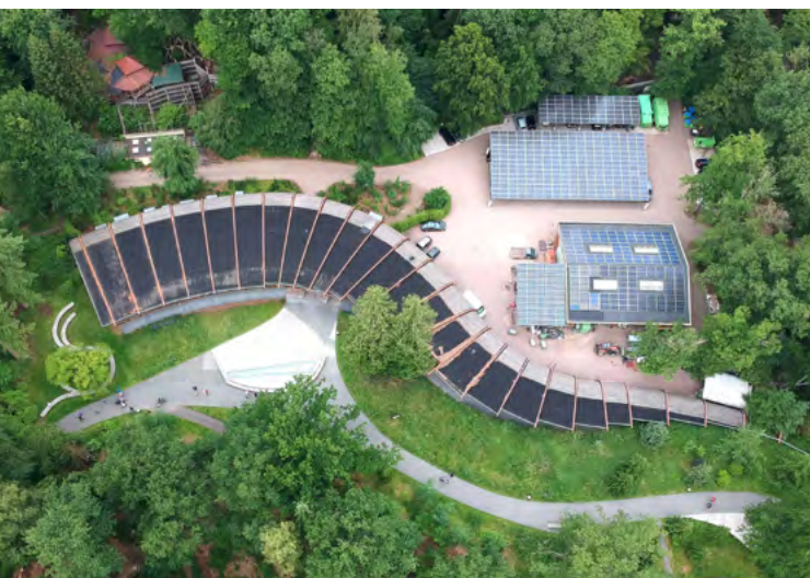
Apenheul. Gebouw De Staart met dienstparkeerplaats vol zonnepanelen van KiesZon.
