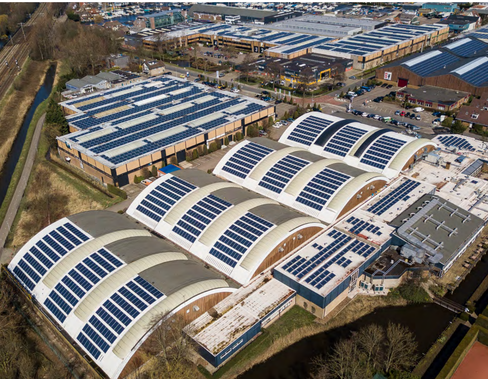
Bedrijventerrein in Warmond, Zuid-Holland, waar ruim 5.000 zonnepanelen werden geplaatst. Foto: Ad van Bokhoven
